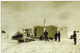
СП-3. Домик кают-компании перетаскивают с помощью трактора
